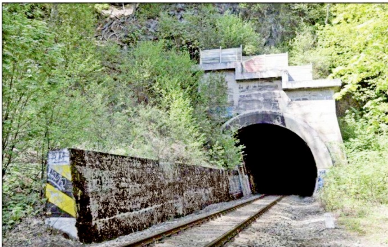
Jeden z portálů říkovských tunelů – foto: archiv autora.
